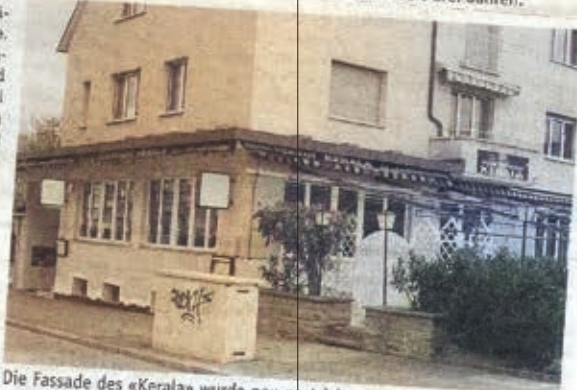
Die Fassade des «Kerala» wurde neu gestrichen.
